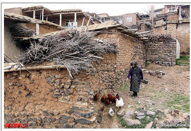
تصویر شماره ۱۵: بکارگیری سنگ در ساخت مسکن روستایی (Saeidi & Kalantari, 1997)
