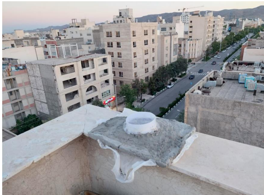
شکل ۶- ظروف نمونه برداری تپله ای در تراس ساختمان پایه (نویسندگان)
