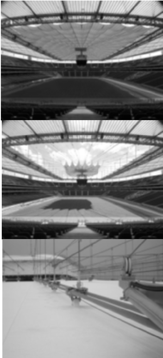
شکل (۱): سقف باز و بسته شونده استادیوم کامرزبانک و مکانیزم مکانیکی متحرک آن [۴].
