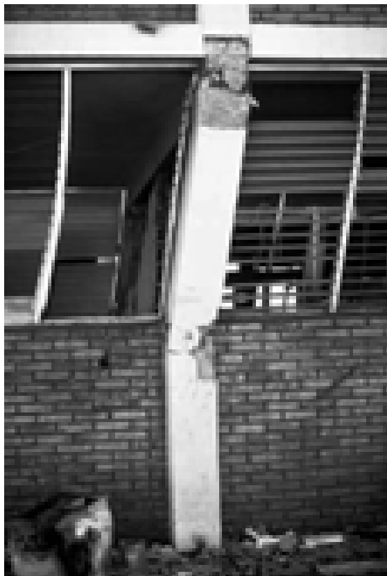
تصویر ۷: شکست خمشی ستون کوتاه [۲۹]
