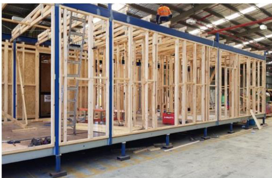
شکل شماره ۱. ساخت مدول‌های پیش‌ساخته در کارخانه [۳۵]
