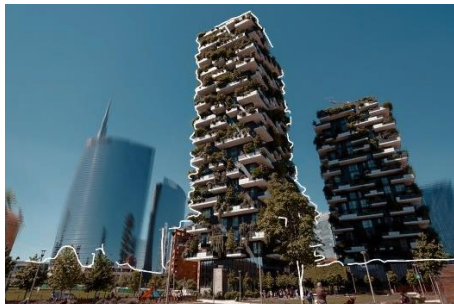
شکل ۱. بوسکو ورتیکاله یا "جنگل عمودی" نام دو برج مسکونی به ارتفاع ۱۱۱ و ۸۰ متر توسط اسفانو بودری و همکاران طراحی شده؛ نمونه شاخص معماری سبز در شهر بزرگی مانند میلان به شمار می‌آید.
