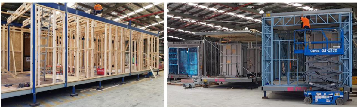
شکل شماره ۱. ساخت مدول‌های پیش‌ساخته در کارخانه [۳۵]
