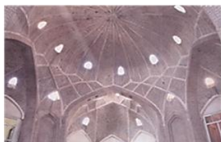
تصویر ۱۶: گنبد با باریکه طاق‌های باربر تیمچه ملک در بازار تبریز. (حاجی قاسمی، ۱۳۹۰، ۱۳۷۵). و نمای زیر گنبد تیمچه ملک. (حاجی قاسمی، ۱۳۷۵، ۱۳۷).
