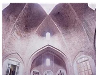
تصویر ۱۷: گنبد با باریکه طاق‌های باربر مقطع از تیمچه حاج شیخ کاظم بازار تبریز. (حاجی قاسمی، ۱۳۷۵، ۱۲۲). و نمای زیر گنبد تیمچه حاج شیخ کاظم. (حاجی قاسمی، ۱۳۷۵، ۱۲۲).
