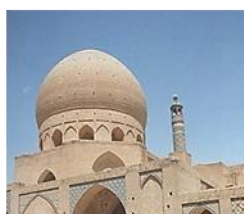
تصویر ۱۴: گنبد دو پوسته گسسته مسجد آقابزرگ کاشان. مقطع گنبد (حاجی قاسمی، ۱۳۷۵، ۱۵۷). و نمای خارجی گنبد آقابزرگ کاشان (حاجی قاسمی، ۱۳۷۵، ۱۵۳).
