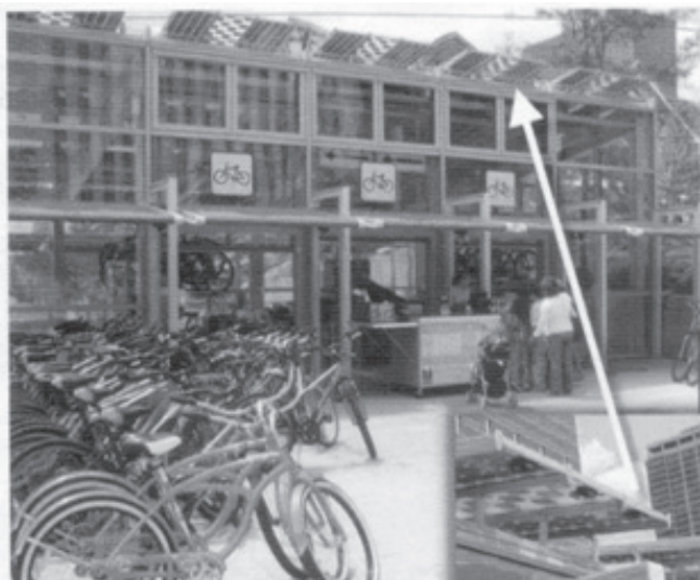
شکل ۱۵. کاربرد ورقه‌های باریک سلول‌های خورشیدی طبیعی برای تولید انرژی الکتریکی در ساختمان پارک ملی نیوم شیکاگو
