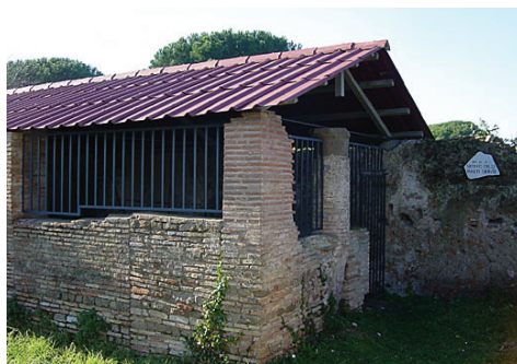
شکل ۲. نمای بیرون مهرابه.
