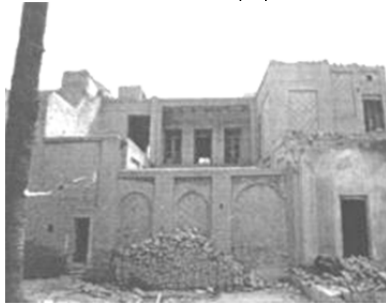
شکل ۹) نمای خانه موسوی [17]
