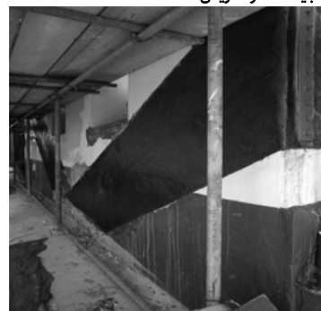
شکل ۲) مقاوم سازی با استفاده از الیاف [23]
