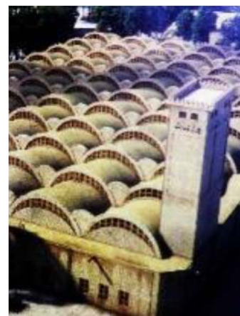
شکل ۵) سالن کارگاهی کارخانه سعادت یزد
