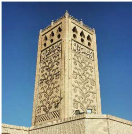
شکل ۸) برج تصفیه کارخانه اقبال یزد[۶]
