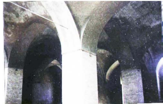
شکل ۳) فضای داخلی انبار کارخانه ریسباف اصفهان
