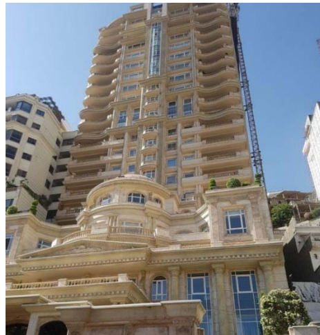
شکل ۶) برج مسکونی تندیس، منطقه ۱
