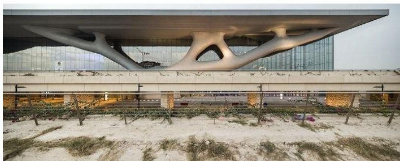
شکل ۳) طراحی پایه های سایه بان مرکز انجمن های بین المللی قطر با استفاده از بهینه سازی توپولوژی [۱۸]
