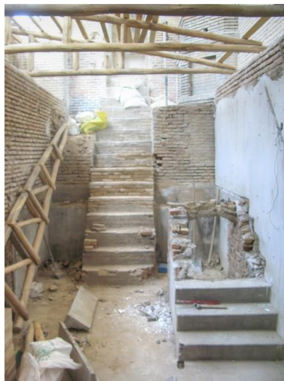
شکل ۷. راه‌پله اصیل بنا که پس از گمانه زنی وجود و سلامت آن تایید شد و بدین طریق نسبت به احیای آن اقدام شد.
