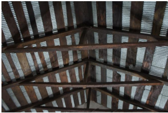
شکل ۲۴: خرپای کارخانه چای قلعه گردن
