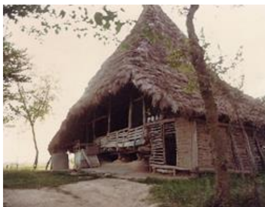
شکل ۵: سقف گالی پوش
