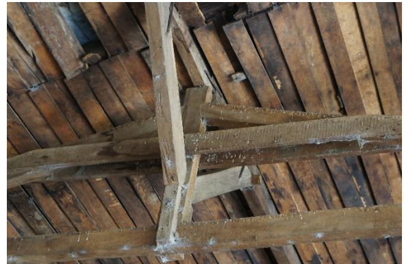
شکل ۲۶: جزئیات خرپای کارخانه پنبه بابلسر
