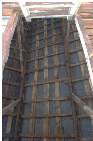
شکل ۱۵: سازه شیبدار کارخانه چای رامنوش
