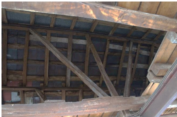
شکل ۱۶: نحوه قرارگیری تیرهای مورب و عمودی
