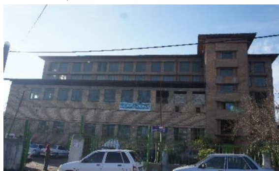
شکل ۱۹: نمای شمالی کارخانه چای بهرنگ
