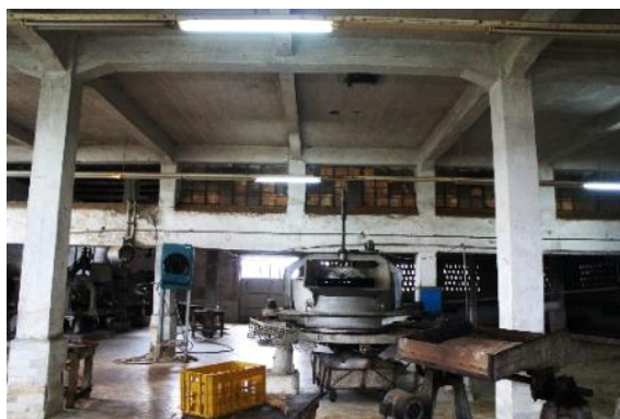
شکل ۱۶: طبقه هم‌کف کارخانه چای گرچی
