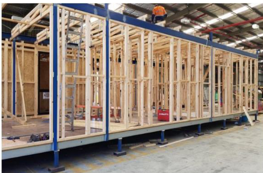
شکل شماره ۱. ساخت مدول‌های پیش‌ساخته در کارخانه [۳۵]
